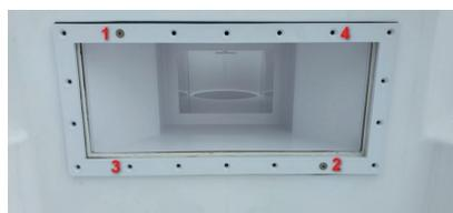
5. Lors du vissage, veillez toujours à serrer les vis symétriquement et en diagonale pour une pression optimale du skimmer sur les joints. Installez toutes les vis, en travaillant toujours en diagonale.
