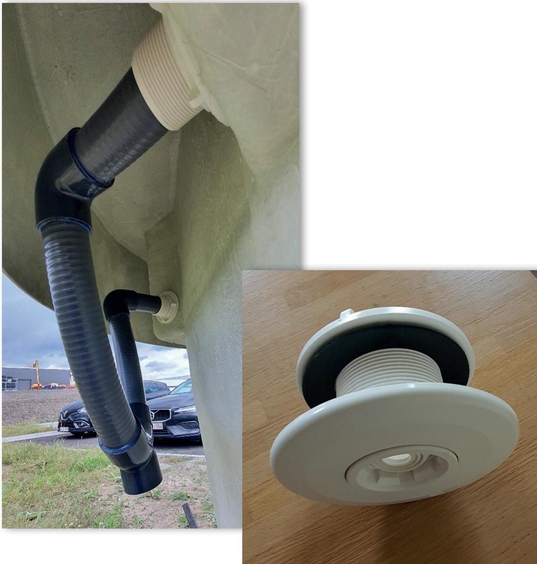
L'anneau en caoutchouc de la buse doit être à l'intérieur de la piscine .
