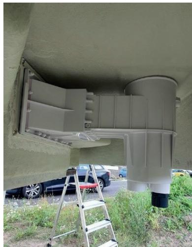
7. Placer le couvercle d'accès parallèlement au rebord et sceller avec AQUAMAX Fast.
